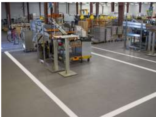
Le plancher technique Labadis intègre tous les types de câbles : le sol est libre et la vue est dégagée
