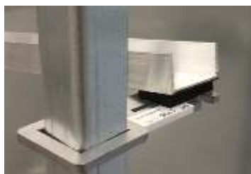
Fixation du rail sur patoche L0195 avec mousse double adhésif
