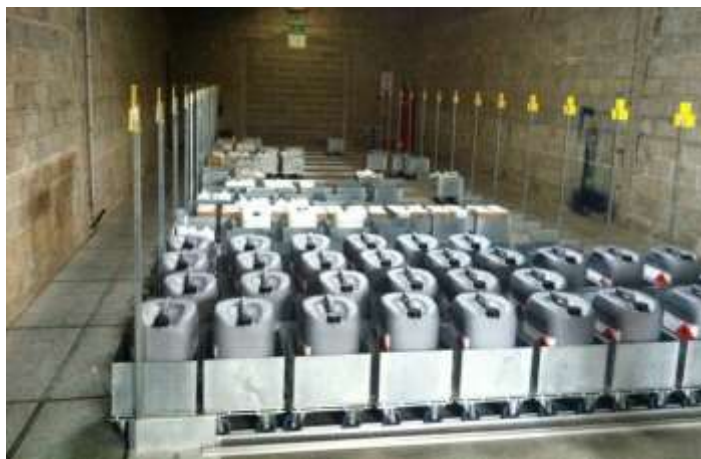
Stockage de produits dangereux
