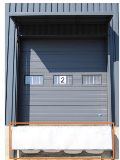
Système amortisseur lors de la venue du camion au quai
