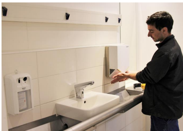
Rampe de lavage des mains en quatre étapes : nettoyage, rinçage, séchage, coiffage.
