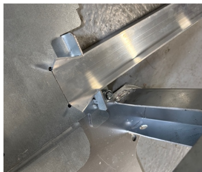
Rail découpé à longueur, prêt à poser : extrémités ouvertes pour un guidage des roues. 2 encoches pour les pattes de fixations.
