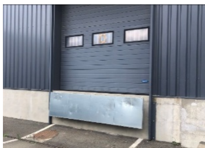
Système amortisseur lors de la venue du camion au quai (Labadis)
