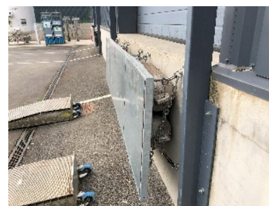
Système amortisseur lors de la venue du camion au quai (Labadis)
